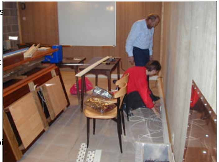
Plaatsen van de kabelgoten door Robert en Nick
